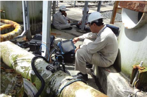
Hình 7. Đoạn đường ống khảo sát thực tế
